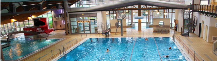
Tageslichtabhängige Beleuchtung in den Schwimmhallen
