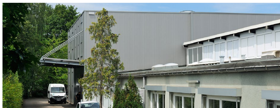
Büro und Lagerhalle
