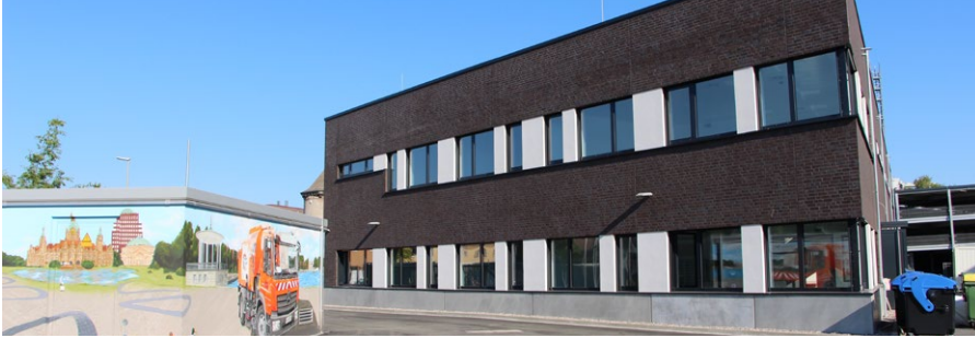
Sozialgebäude in Passivhausbauweise Gertrud-Knebusch-Strasse
