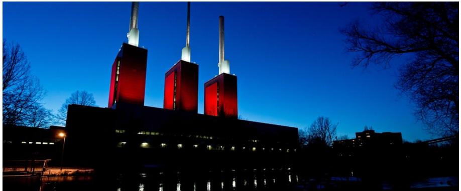
beleuchtetes Heizkraftwerk Linden bei Nacht
