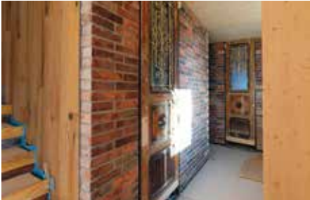
Historische Bauteile wiederverwendet
