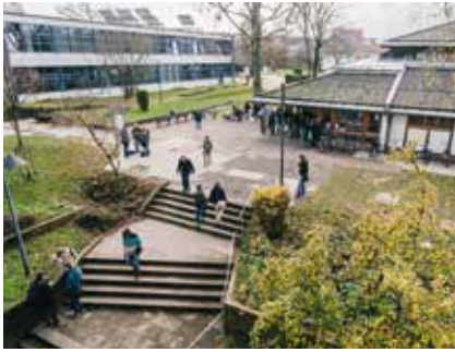
Bibliothek und Westfassade Gebäude 1E
