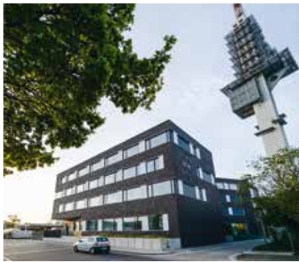
aha-Zentrale im Passivhausstandard
