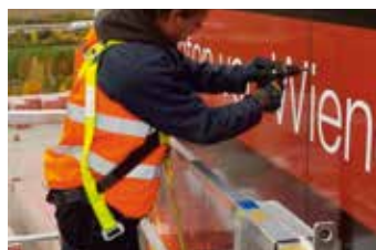
Arbeitssicherheit in schwindelnder Höhe
