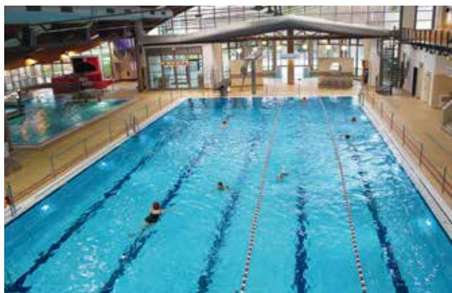
Tageslichtabhängige Beleuchtung in den Schwimmhallen
