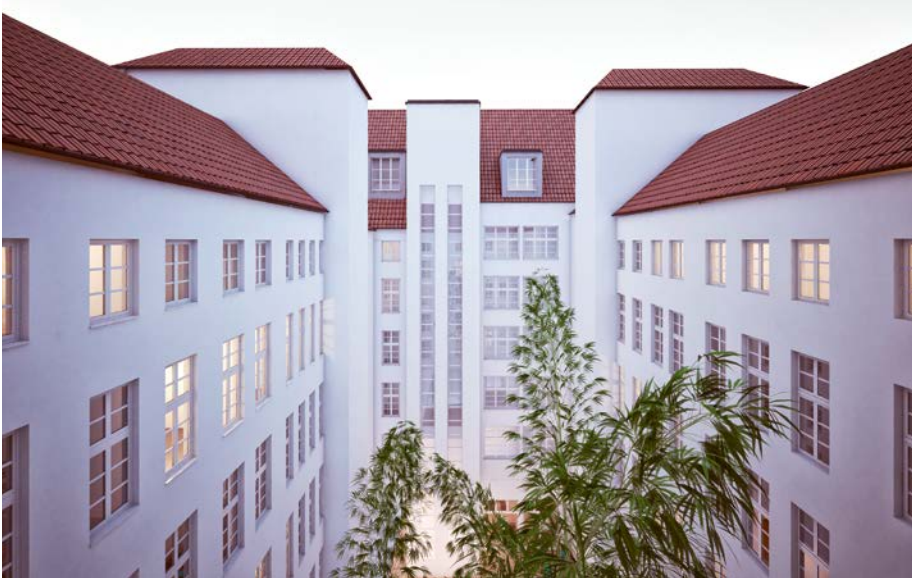
Mitten im Herzen von Hannover, direkt gegenüber der Oper, entsteht im ehemaligen „Kurierhaus“ von 1929 das erste Budget Design Hotel von Motel One in Hannover. Die meravis Immobiliengruppe baut das denkmalgeschützte Gebäude derzeit um, wird es langfristig als Gewerbebestand im eigenen Portfolio halten und an Motel One vermieten. Die Eröffnung des 180-Zimmer-Hotels ist frühestens 2021 geplant.
