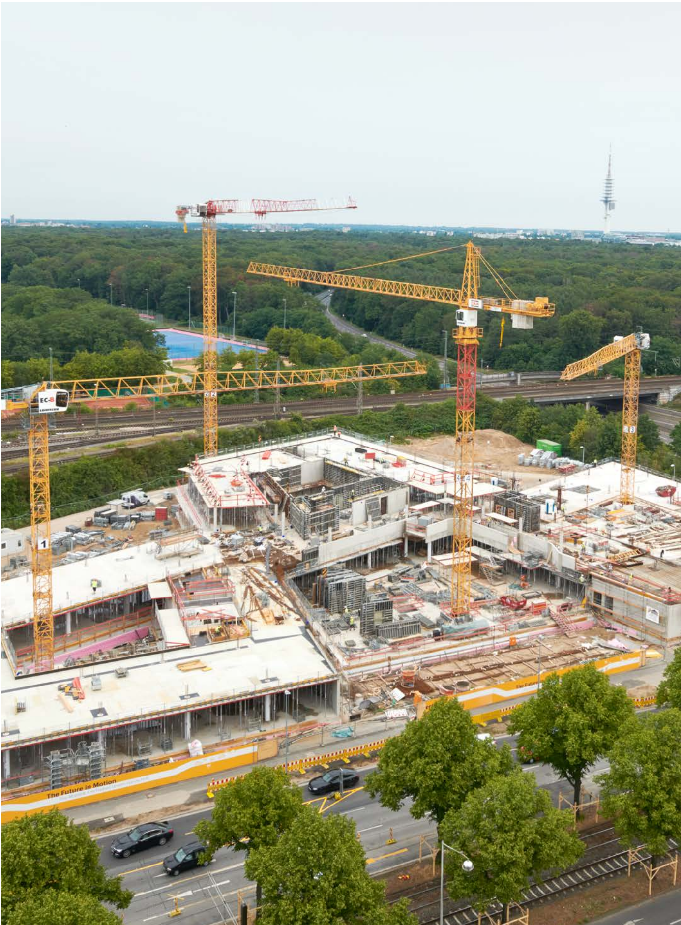
Ende Juli 2018 erfolgte der Spatenstich für den als Campus angelegten neuen Standort der Continental AG. Am zentral gelegenen Pferdeturm werden 1.250 Arbeitsplätze geschaffen. Die bisher in der Stadt verteilten Nutzungen werden hier gebündelt und mit dem Neubau wird die Geschichte des seit 1871 in Hannover ansässigen Unternehmens fortgeschrieben. Der Entwurf des Büros Henn aus Berlin sieht u. a. vor, die Hans-Böckler-Allee mit einer ca. 70 m langen Brücke zu überspannen, um die Gebäude untereinander zu verbinden.
