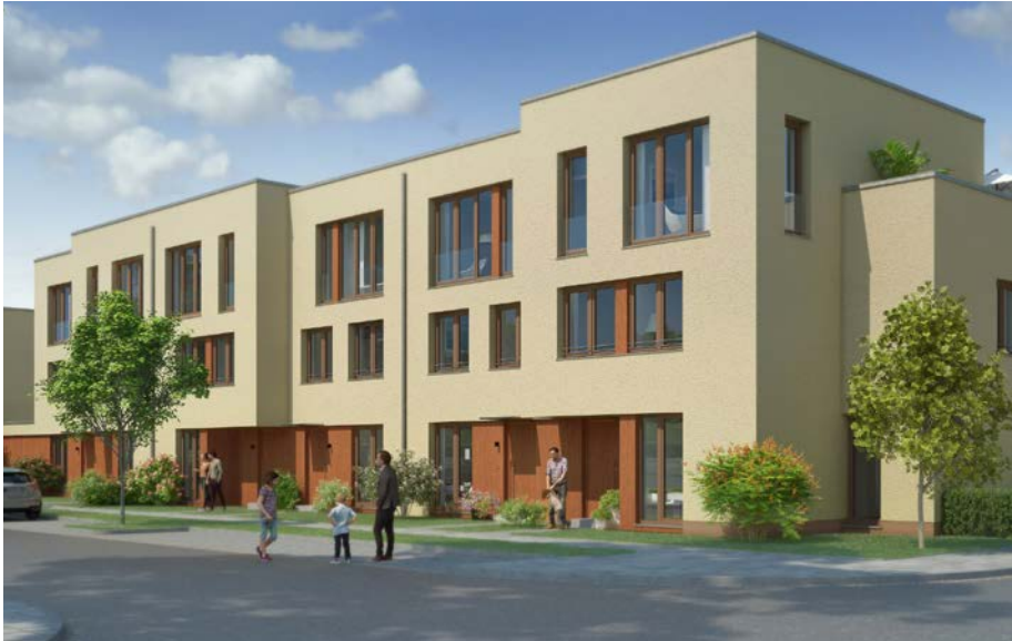
Die INTERHOMES AG erstellt aktuell ein kleines Wohngebiet mit insgesamt 13 Reihenhäusern im Norden des Kronsberg-Quartiers. Allesamt als Passivhäuser konzipiert, stehen vier Haustypen zur Auswahl, entworfen von Lorenzen Mayer Architekten GmbH.
