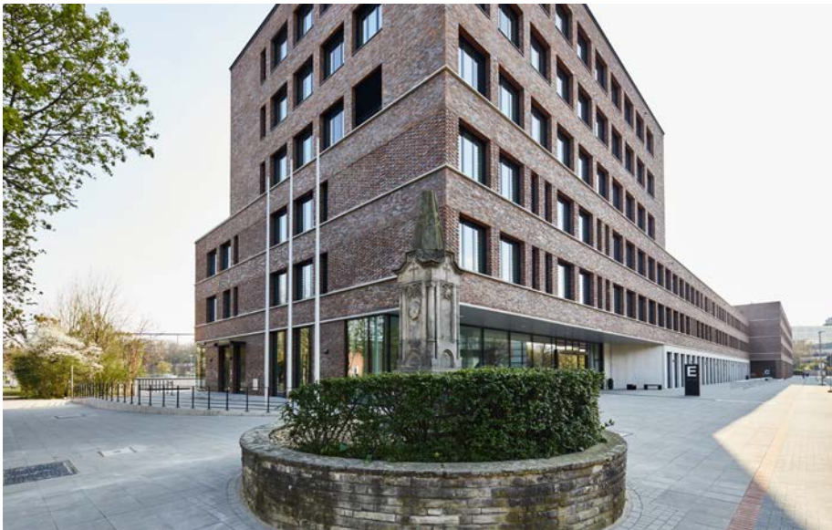
Rund zwei Jahre nach dem Aushub der Baugrube ist das neue Verwaltungsgebäude am Schützenplatz mit seiner 200 m langen roten Backsteinfassade, den bis zu sechs Stockwerken und der 22.000 qm großen Nutzfläche fertig gestellt worden. Die Stadt mietet es für 30 Jahre von hanova und nennt ihre neue Adresse „HannoverServiceCenter am Schützenplatz“.
