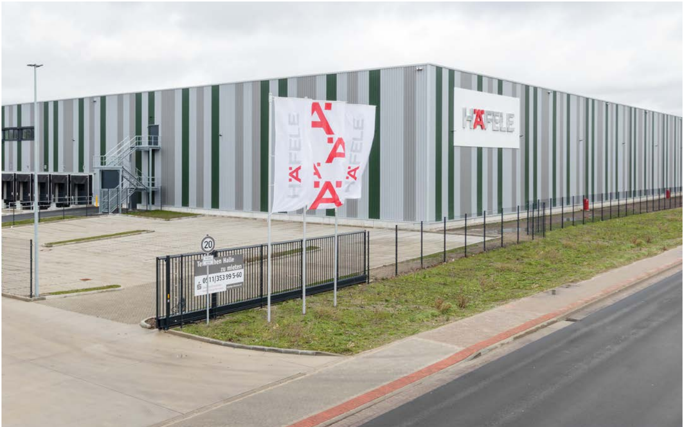
In Lehrte, unmittelbar an der A 2 gelegen, ist ein 22.000 qm großes Versandzentrum für den Beschlaghersteller Häfele fertig gestellt worden, das der Entwickler, die bauwo Grundstücksgesellschaft mbH, bereits im Januar 2019 für 20 Mio. Euro an die LIP Invest GmbH aus München verkauft hat.
