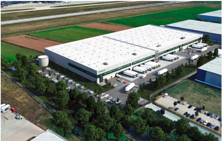
Prologis entwickelt den bestehenden Logistikstandort am Flughafen weiter und erstellt derzeit spekulativ neue Logistikflächen im Airport Business Park. Geplant sind rund 25.000 qm Hallen-, Büro- und Mezzaninefläche.
