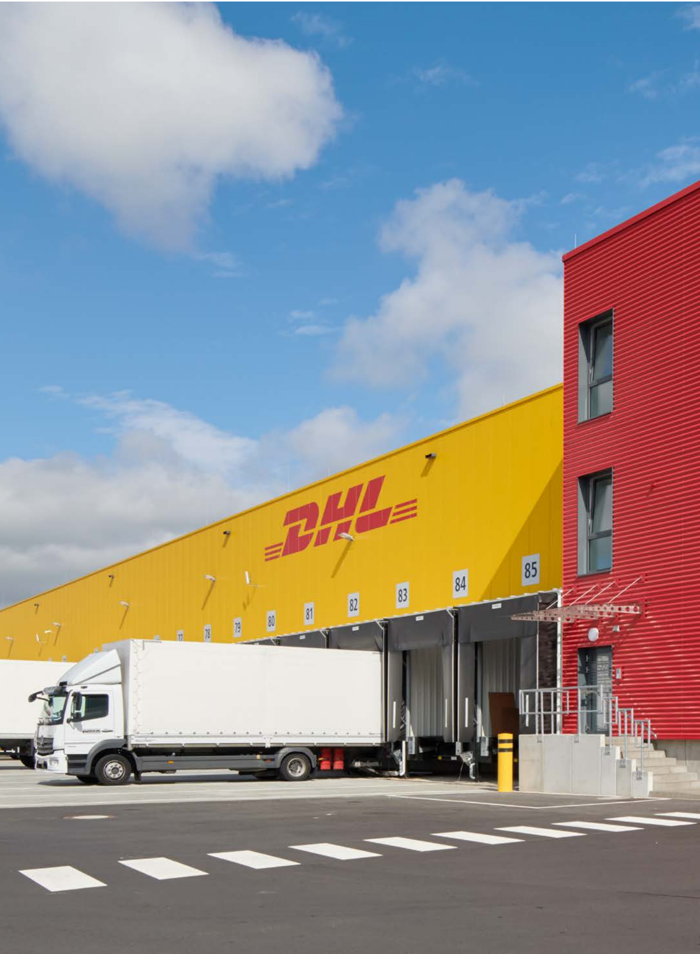
In einer rund 8.300 qm großen Umschlaghalle mit über 80 Ladeschleusen werden etwa 260 DHL-Mitarbeiter zukünftig Fracht für das europaweite Stückgutnetzwerk Euroconnect sowie den Premiumstückgutservice Eurapid disponieren und konsolidieren. Zudem spielt der Standort eine wichtige Rolle für den Komplettladingsservice Euronet von DHL Freight.
