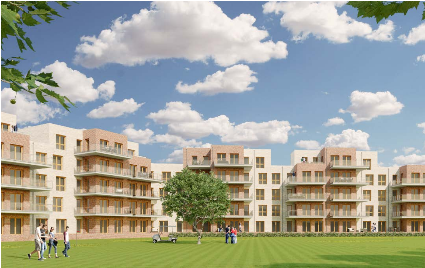
Fischer Bau erstellt zurzeit einen der letzten Bausteine im Quartier Seelhorster Garten. Das Bauprojekt umfasst neben den 61 Wohnungen auch rund 5.000 qm Büroflächen, die Fertigstellung ist für Ende 2020 geplant.
