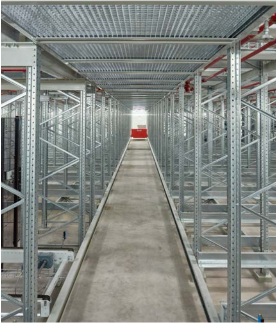
Die äußere Hülle des neuen Versandlagers des hannoverschen Schleifmittelherstellers VSM ist bereits fertig. Die vollautomatisch arbeitende Anlage soll Anfang 2018 in Betrieb gehen.
