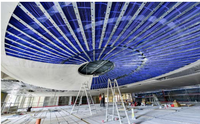
Arbeiten an der Deckenkonstruktion des Plenarsaals des Niedersächsischen Landtags im Mai 2017
