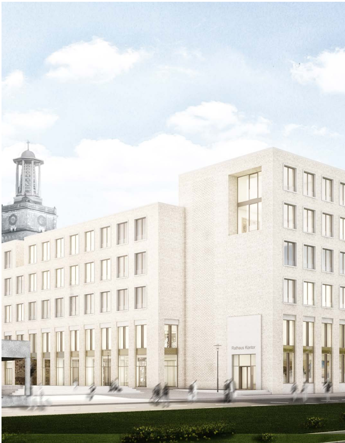
Die BAUM Unternehmensgruppe baut direkt gegenüber dem Neuen Rathaus am Friedrichswall das ehemalige Gebäude der Volkshochschule zum Rathaus Kontor um. Besonderheit des Projektes: Im Erdgeschoss befinden sich denkmalgeschützte Reste der alten Stadtmauer von Hannover, die nach Sanierung und Teilabriss in das neue Gebäude integriert werden.
