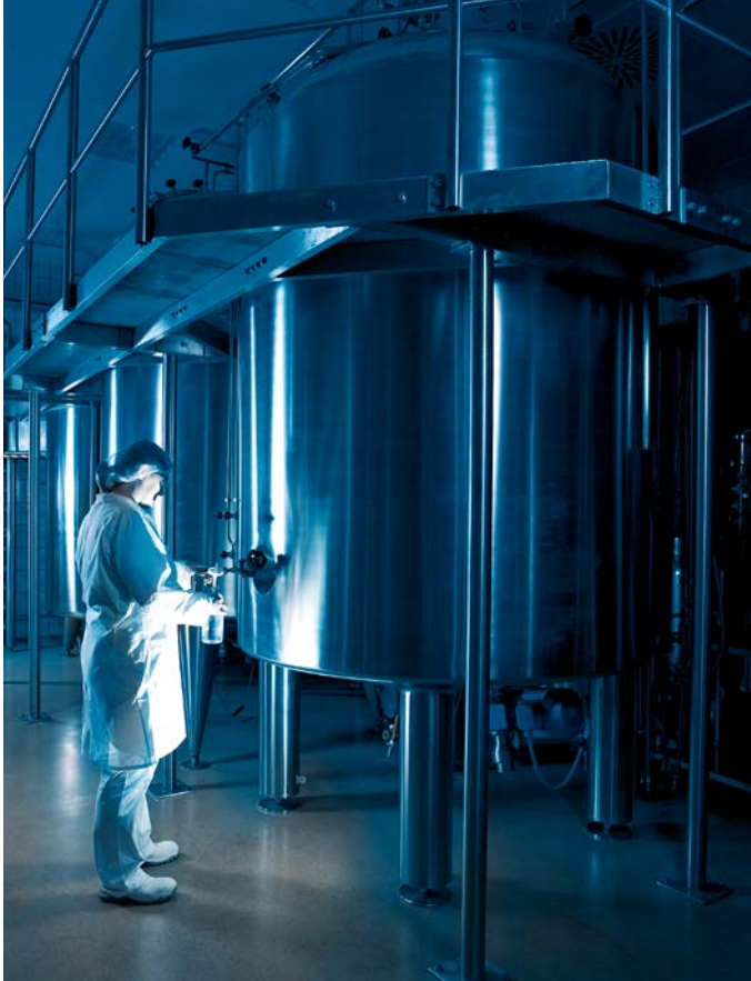
Das weltweit agierende Pharmaunternehmen MSD baut an seinem Standort in Burgwedel bei Hannover sein Produktportfolio aus und führt eine Modernisierung nach den neuesten Sicherheitsstandards durch.
