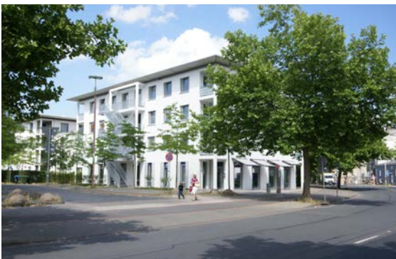
Wohnraum für Geflüchtete: Mitte 2016 wurde die Flüchtlingsunterkunft an der Kopernikusstraße in der Nordstadt in Betrieb genommen. Das architektonische Konzept des Gebäudes orientiert sich an den umliegenden Bestandsbauten der hanova . Nach zehn Jahren wird der Bau von hanova als Wohngebäude nachgenutzt. Insgesamt werden dann bis zu 20 Wohnungen entstehen.
