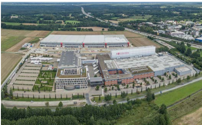
Die Bauarbeiten laufen, Anfang Dezember soll der Betrieb im neuen Logistikzentrum in Burgwedel starten. Das Familienunternehmen FIEGE aus Westfalen lässt eine rund 40.000 qm große Halle direkt an der A 7 erstellen. Als Kontraktlogistiker will FIEGE an seinen neuen Standort vor allem für Kunden aus dem E-Commerce-Bereich arbeiten. Einer der vier Hallenabschnitte ist von Rossmann angemietet worden. Aber auch als Investment ist das Projekt attraktiv. Die Projektentwicklung wurde bereits vor Fertigstellung für rund 46 Mio. Euro an Union Investment verkauft.
