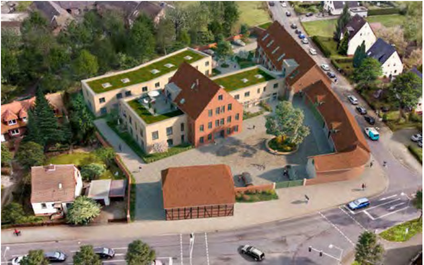
Das Architekturbüro [pfitzner moorkens] architekten aus Hannover wurde von Gundlach mit der Umnutzungs- und Neubauplanung für den ehemaligen Hof Raupert beauftragt. Der Umbau dieser historischen Hofstelle zur kleinen Wohnsiedlung im Rahmen einer Neuwidmung gilt als Musterprojekt für viele ähnliche Resthöfe an den Rändern der Stadt, die nach beendeter landwirtschaftlicher Nutzung auf eine Revitalisierung warten. Insgesamt entstehen 19 Wohneinheiten als Eigentum auf Rauperts Hof.
